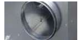
Guarnizioni a tenuta sulle bocche d'aspirazione.
